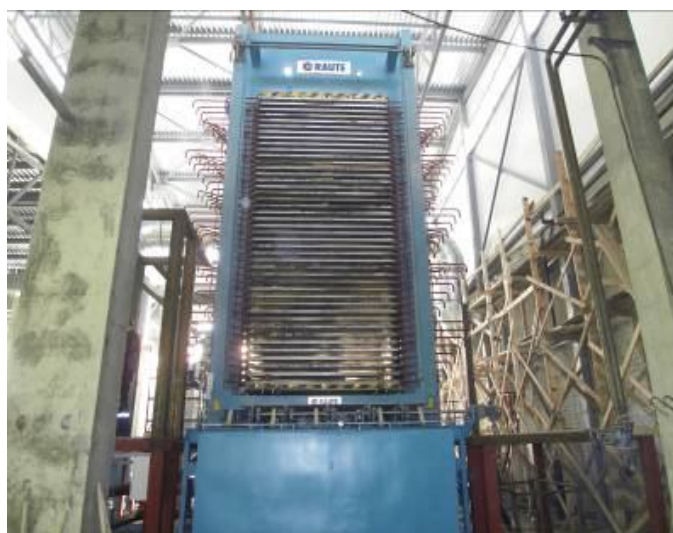
Монтаж 42х пролётного пресса «RAUTE»
