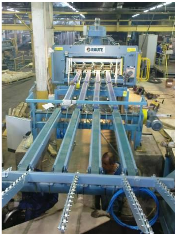
Монтаж лущильной линии фирмы «RAUTE»
