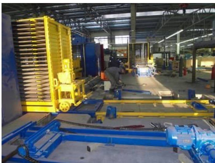
Монтаж 2х линий прессования «Волев»
