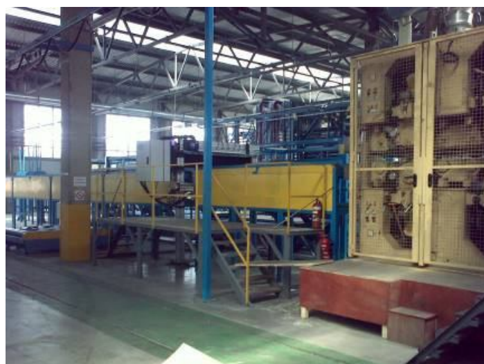
Монтаж шлифовальной линии «Steineman»
