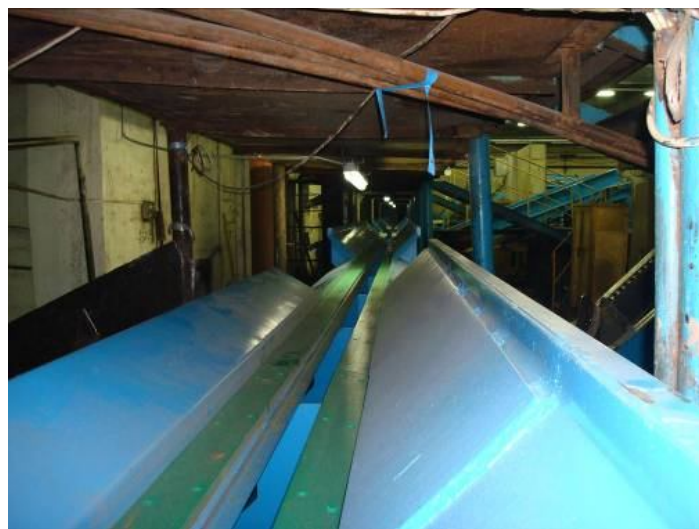
Монтаж бревнотаски «КомЗ»
