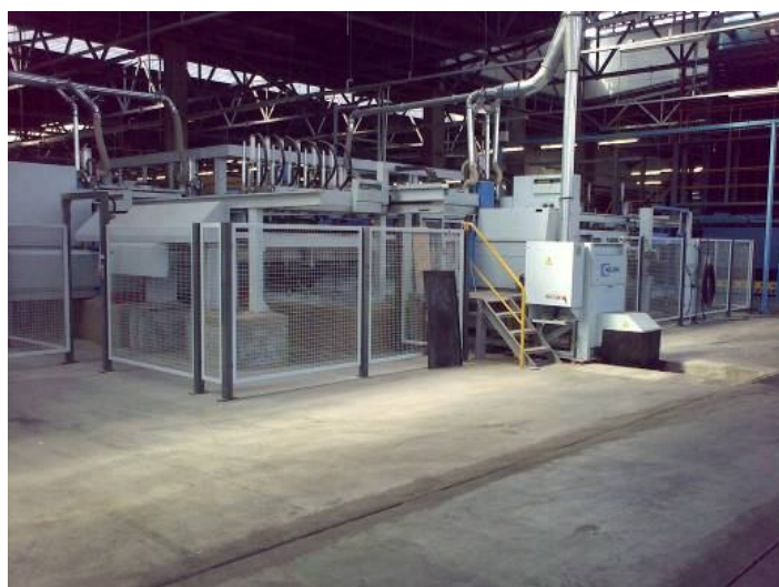
Монтаж кромкообрезной линии «Holzma»
