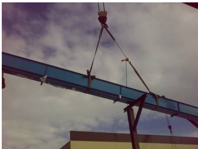
Монтаж транспортёра для удаления щепы «КомЗ»
