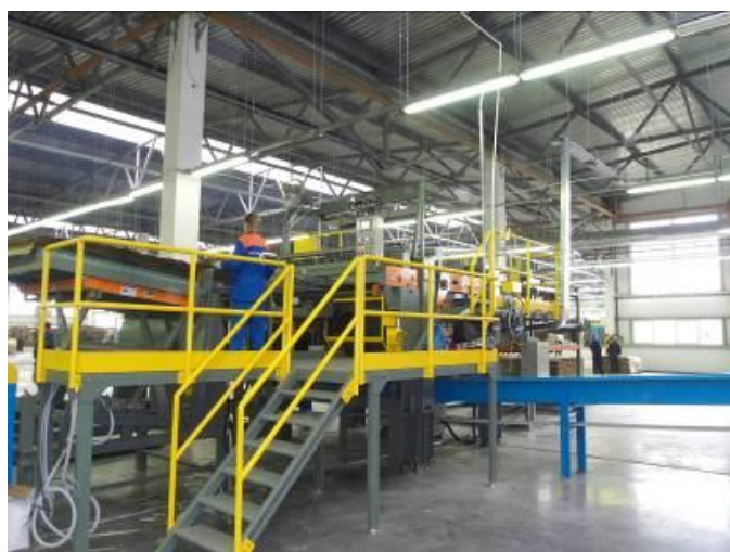
Монтаж линии ребросклеивания «Хашимото»
