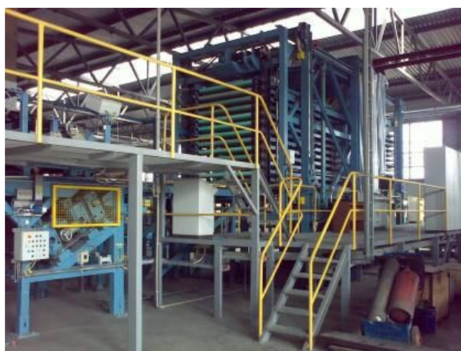
Монтаж прессы ламинирования «RAUTE»
