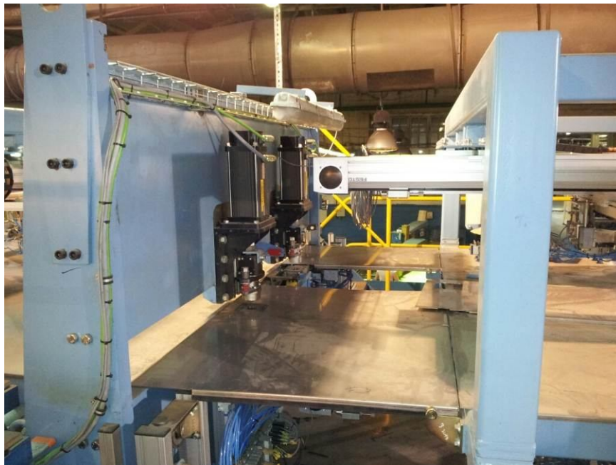
Монтаж и электромонтаж линии автоматической шпонопочинки «Raute» 2012г. Изготовление площадок обслуживания.
