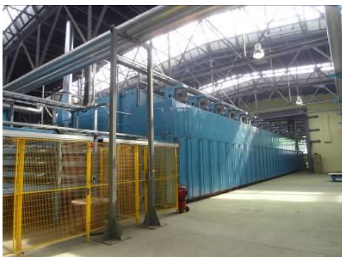
Монтаж сушильной линии и линии сортировки «RAUTE»
