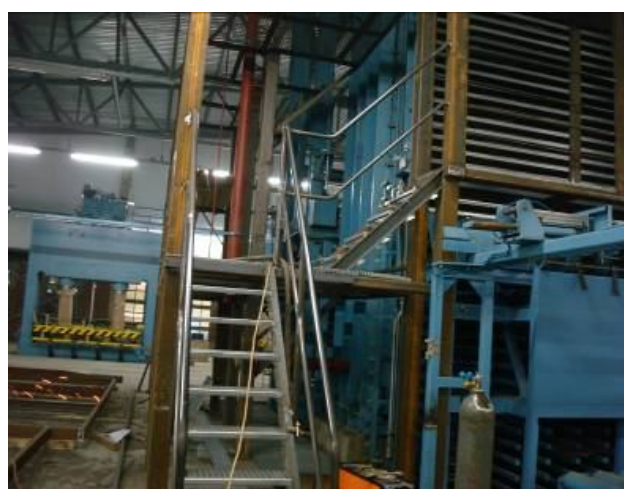
Монтаж 30-ти пролётного пресса «RAUTE»
