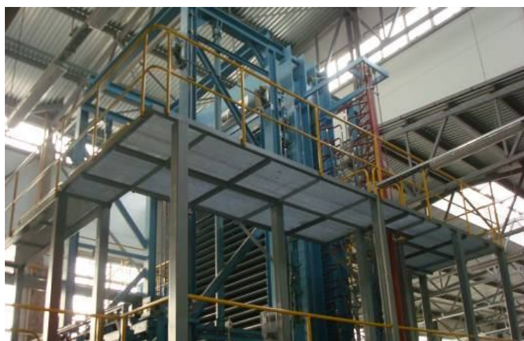
Изготовление площадки обслуживания 30-ти пролётного пресса «RAUTE»
