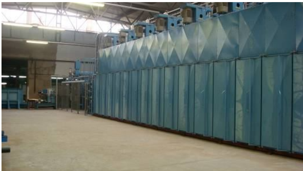
Монтаж сушильной линии и линии сортировки шпона «RAUTE»
